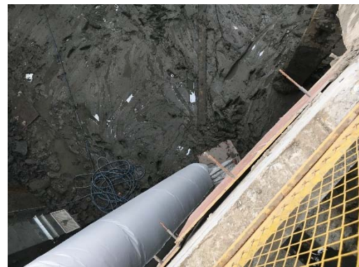
基坑底部采用抽风设备换气
