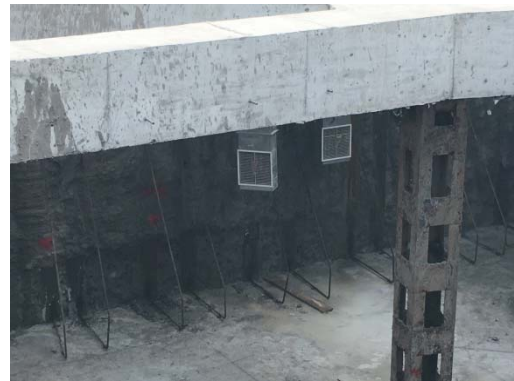
基坑下部支撑面采用素混凝土封底
